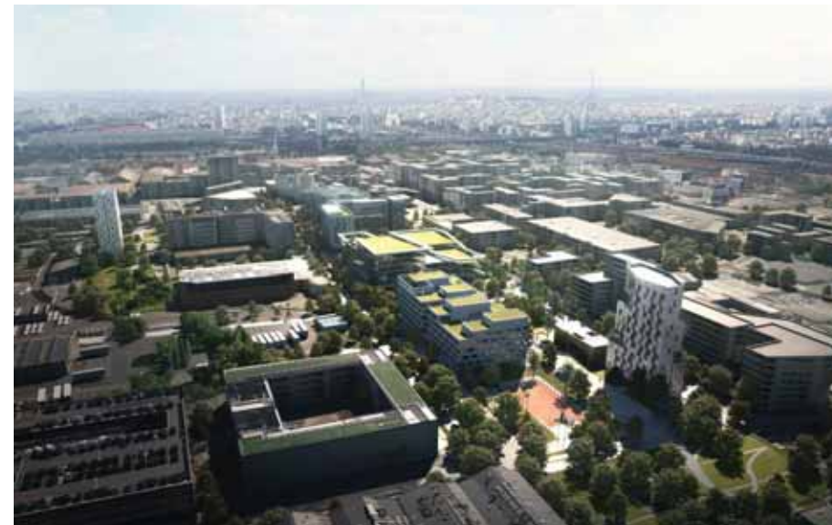
Figure 1 : Vues du Campus Condorcet – Site d'Aubervilliers
