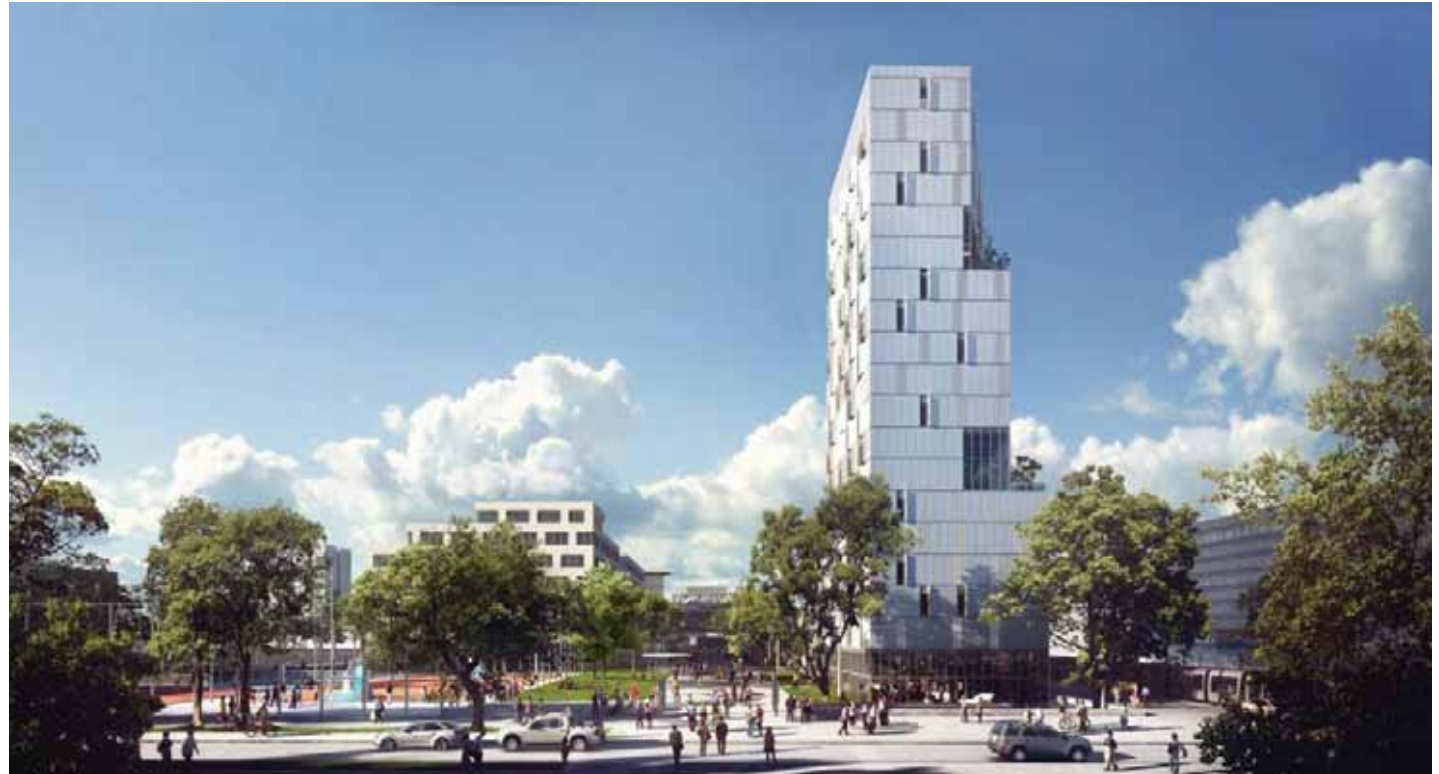
Figure 18 : Entrée Nord, rue Saint-Gobain en direction du Campus
