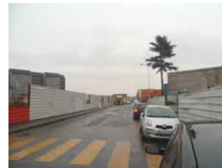
Figure 13 : Palissades sur la rue du Pilier
