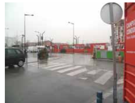
Figure 14 : Palissades à l'angle de la rue du Pilier et de la place du Front Populaire
